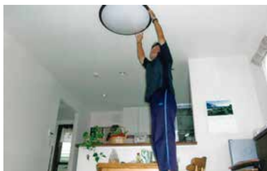
電灯の交換作業
