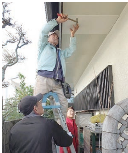
軒天井の補修作業（大阪府豊能郡豊能町）
